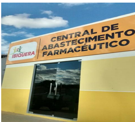
Figura: Algumas das plotagens e placas de sinalização instaladas
